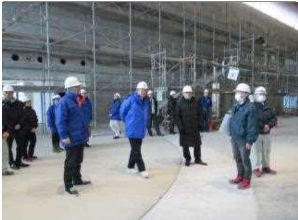
R2.2.20 砺波図書館建設現場視察
