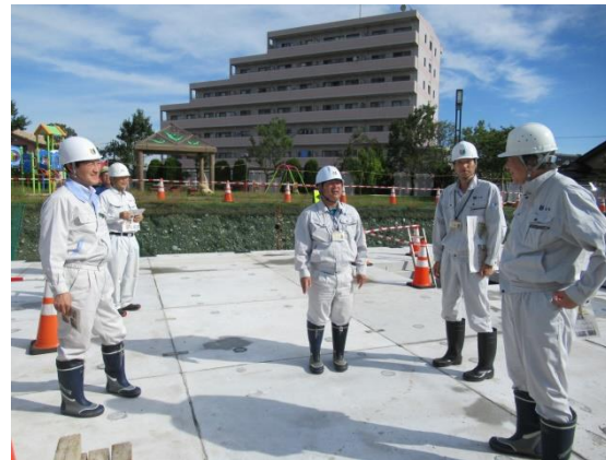
H30.09.26 豊町公園工事現場視察
