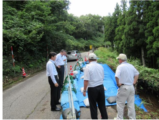
H30.08.29 現場確認
