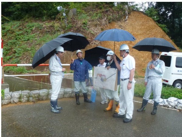
H28.09.12 現地視察(井栗谷災害復旧)
